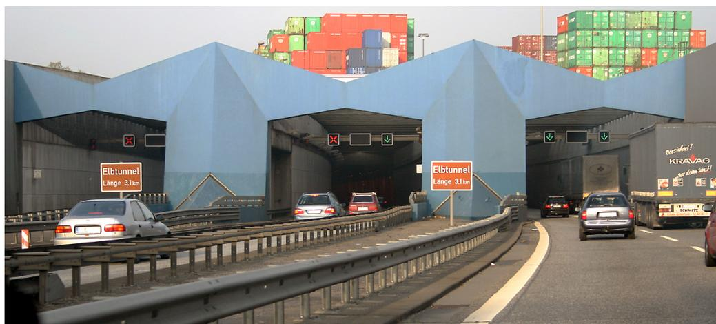
Der Tunnel verfügte zunächst über drei Röhren mit insgesamt sechs Fahrspuren, die über dynamische Verkehrsbeeinflussungsanlagen in der Betriebszentrale verkehrstechnisch gesteuert werden können. Sie ist mit mindestens 3 Personen besetzt. Neben einem Mitarbeiter der Betriebsleitzentrale sitzen hier ein Polizeibeamter und ein Mitarbeiter der Feuerwehr. Der Verkehr wird auf 75 Monitore und diverse elektronische Übersichtstafeln beobachtet und gesteuert.
